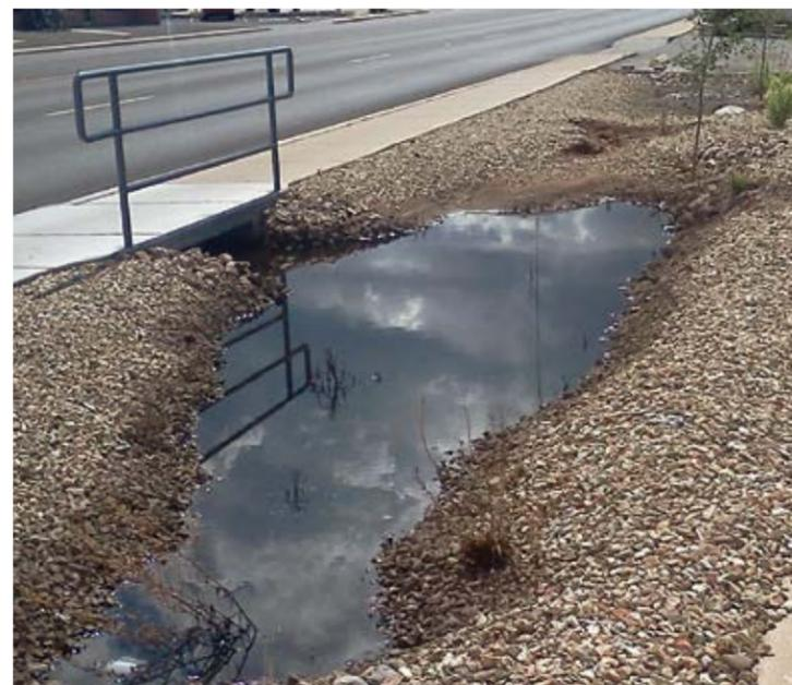
**Suelos altamente arcillosos previnieron que el agua se infiltrara en esta cuenca - provocando que el agua se estanque y que las plantas mueran. Para resolver este problema, la profundidad de la cuenca fue reducida y las plantas nuevas se colocaron a lo largo del eje de la línea del agua para facilitar la infiltración del agua de forma oportuna.**
